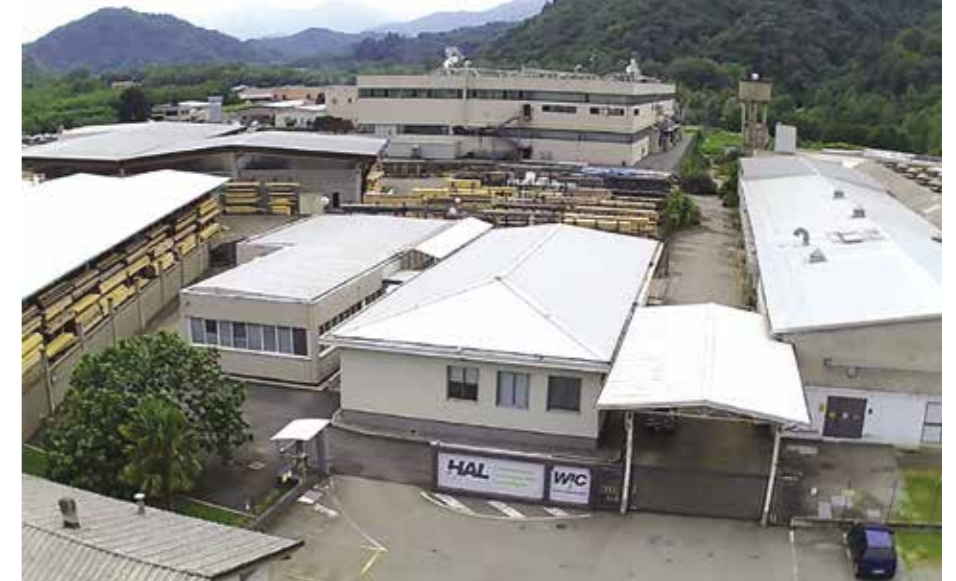
Hal Service SpA - sede
